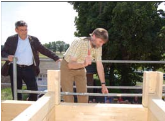
Ortsbürgermeister Holger Behrens schlägt den letzten Nagel ins Gebälk.
